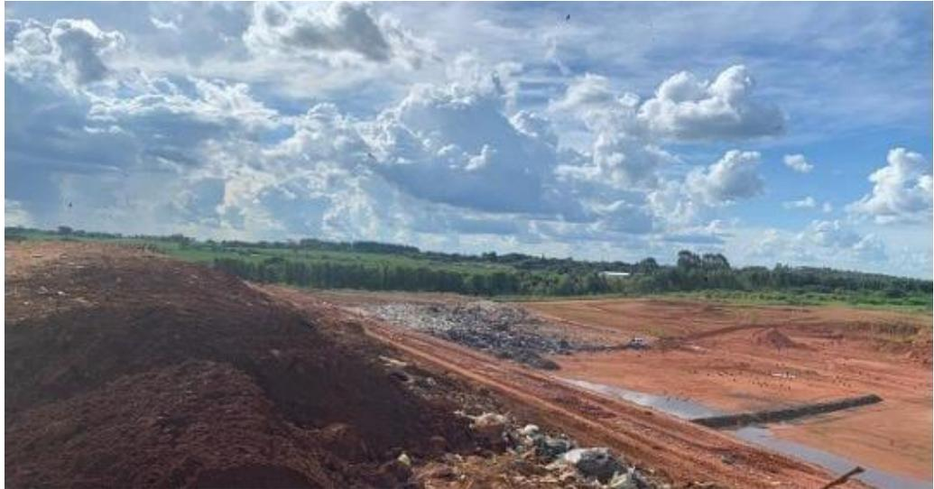
A execução de cada célula consiste em, inicialmente, fazer a terraplanagem da área, marcada pelo serviço de topografia. Sobre o solo, é feito uma base com a mistura de terra e estabilizante químico sólido, compactados em camadas de 20 cm. Após essa impermeabilização inicial, é colocada uma manta de polietileno de alta densidade (PEAD) e, sobre ela, uma camada de terra que tem grande importância para proteção mecânica e que também será compactada a cada 20 cm.
