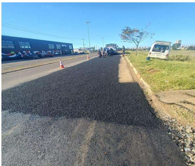
Execução de remendo asfáltico com troca de base na Av. Severino Tostes Meireles,
