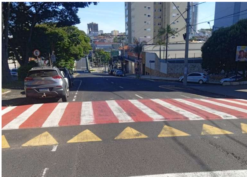
Construção de uma lombofaixa na Av. Major Nicácio, defronte aos numerais 2680 e 2691 – Centro
