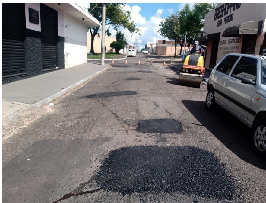
Execução de remendo asfáltico na Rua Fued Zacarias Cury
