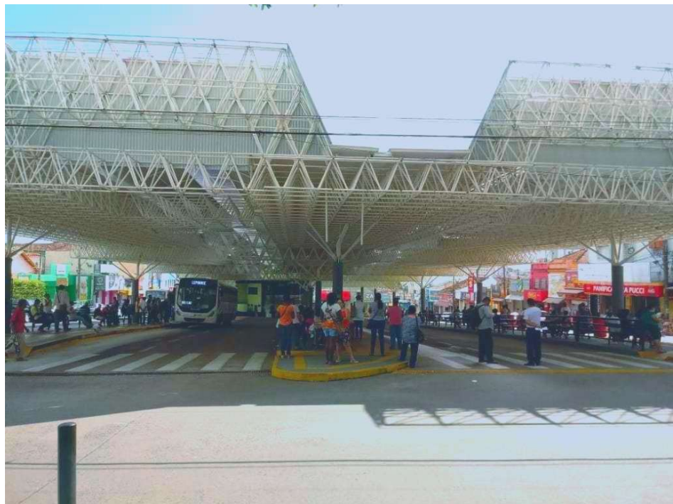
Foto: Terminal de Transporte Coletivo Ayrton Senna.
