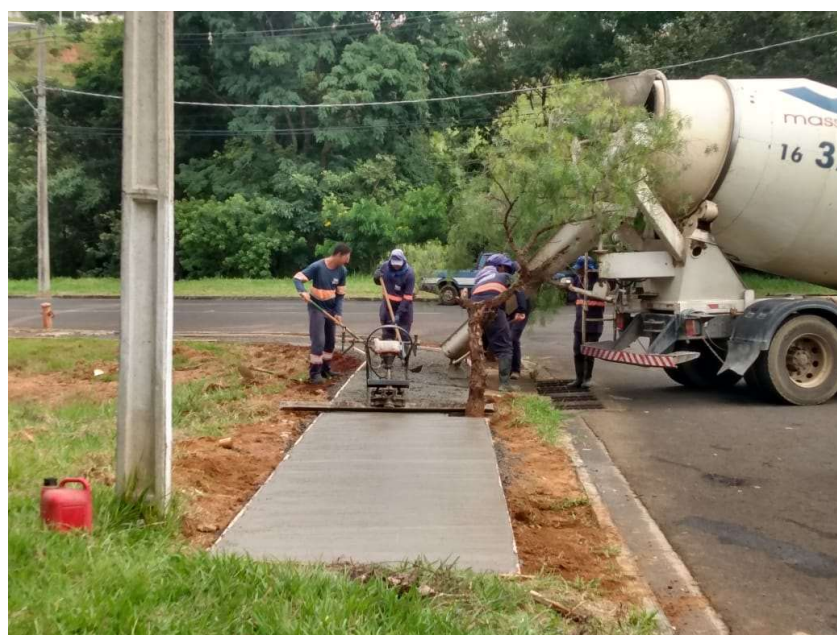
Concretagem de trecho de calçada na Rua Justino Alves Taveira
