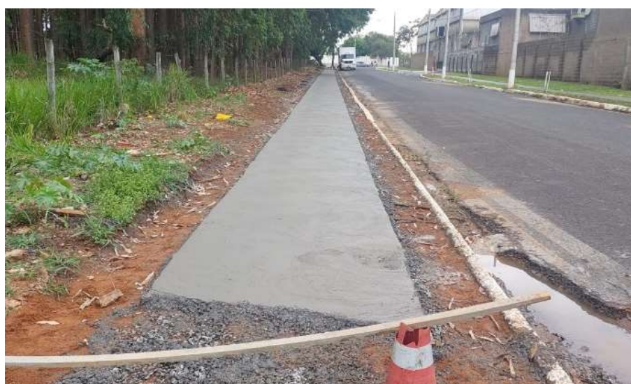
Calçada executada na Rua Osmar Martins
