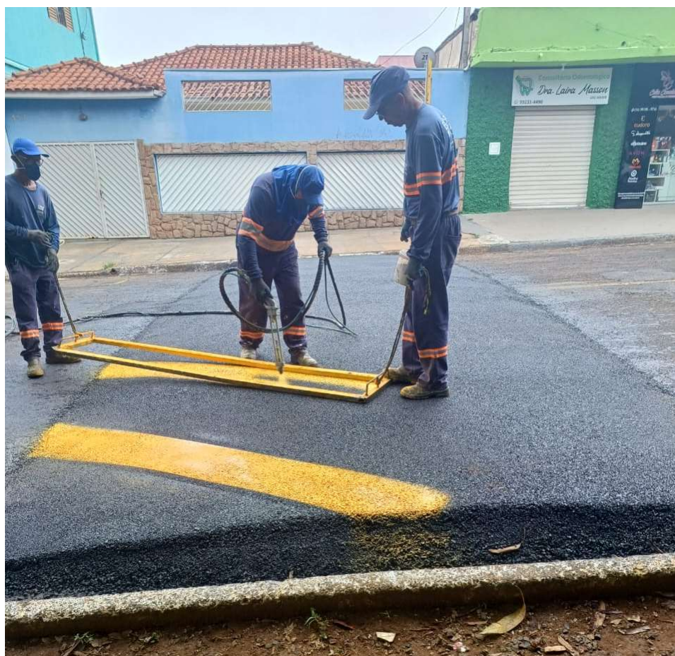
Construção de uma lombada tipo A na Av. Geralda Rocha, nas proximidades do nº 3211 - Parque Vicente Leporace I
