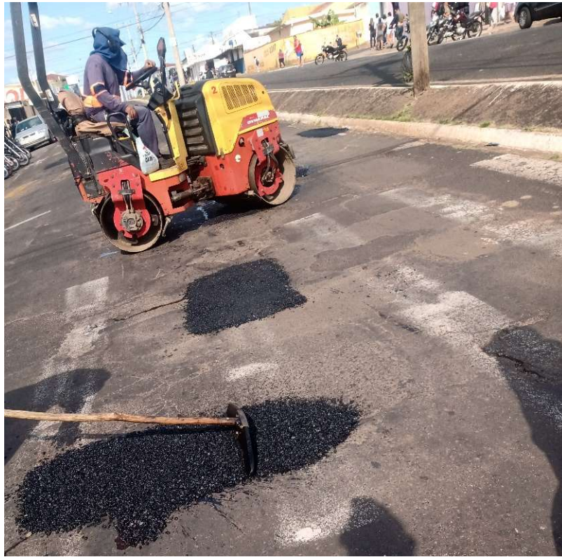
Execução de remendo asfáltico na Av. César Martins Pirajá
