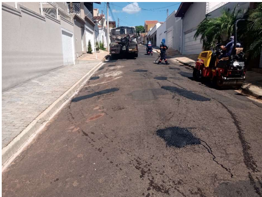
Execução de remendo asfáltico na Rua Arnaldo Teixeira Lemos
