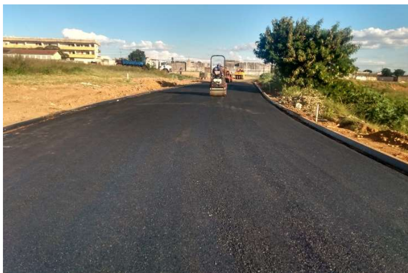
Execução de pavimentação asfáltica nas Ruas Piauí, José Luiz Damasceno e José Paulo – Jardim Líbano
