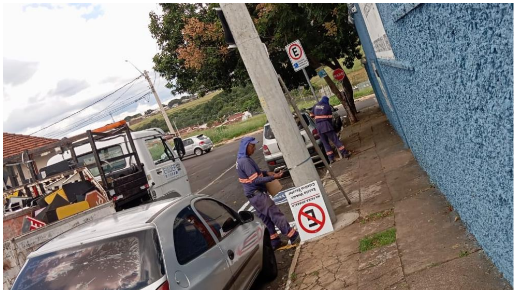
Sinalização viária vertical
