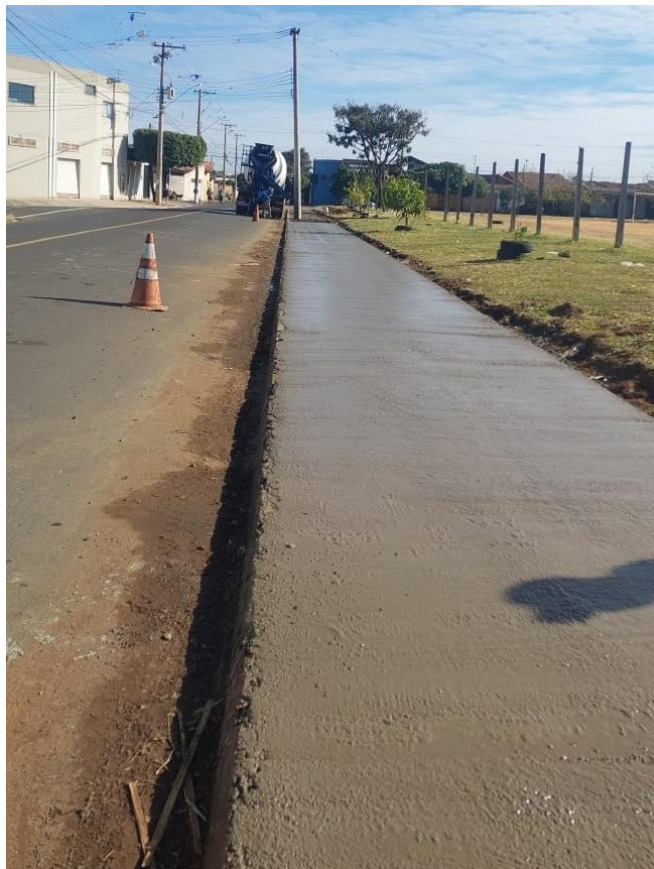
Calçada executada no Jardim Cambuí.
