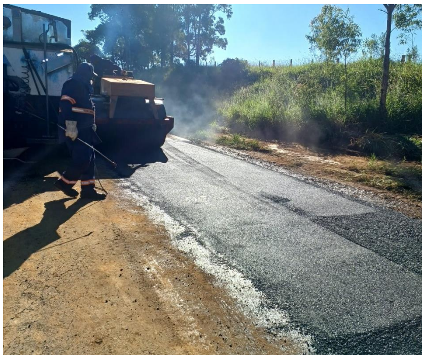
Execução de remendo asfáltico com troca de base na Rodovia João Traficante
