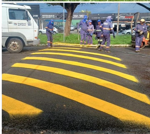
Construção de lombada tipo A
