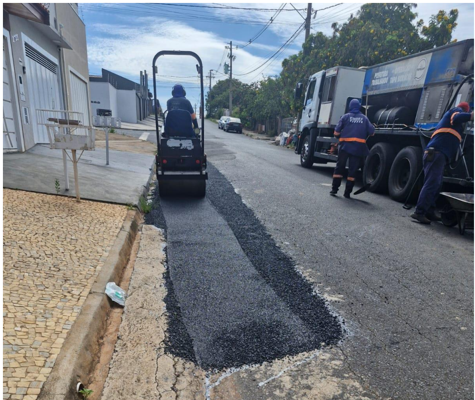
Execução de remendo asfáltico na Rua Antônio Moreira Macedo, 2751, Jd. Espreado
